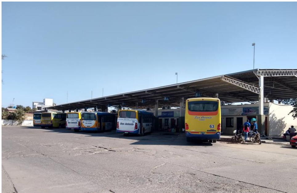
Terminal de SRNO
